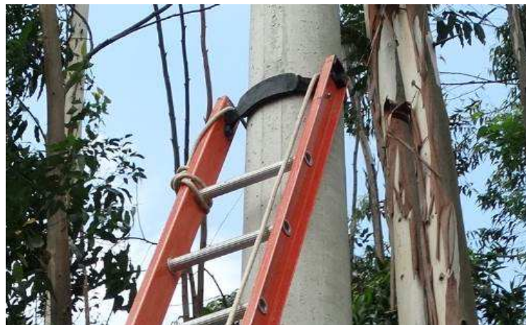
Figura 22 – Posicionamento da escada
