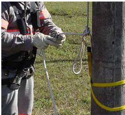
Figura 39 – Instalação do trava-quedas
