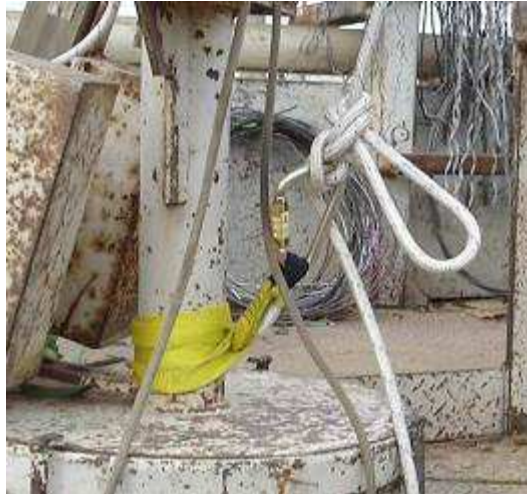
Figura 11 – Ponto de ancoragem
