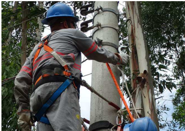
Figura 48 – Fixação do ponto de ancoragem
