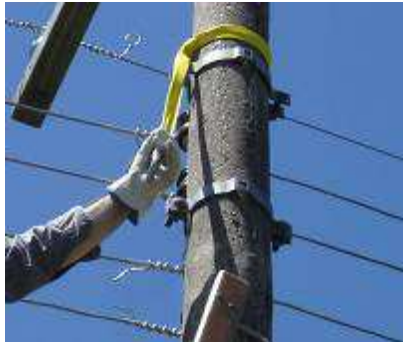
Figura 16 – Ancoragem com fita e mosquetão no poste
