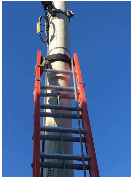
Figura 23 – Posicionamento da escada
