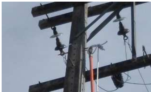
Figura 31 – Instalação do agulhão no poste
