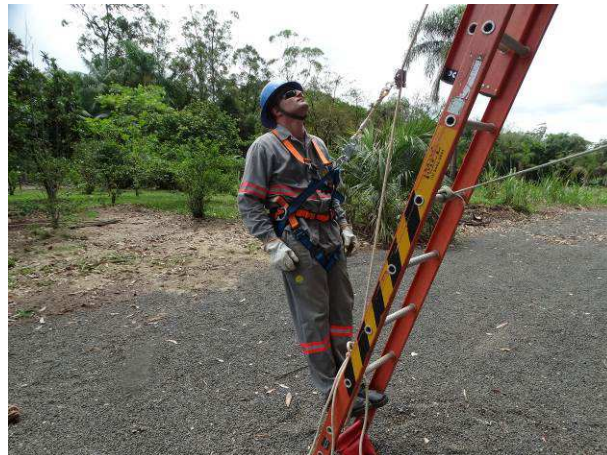
Figura 36 – Teste do sistema de segurança para trabalhos em altura
