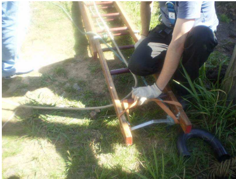
Figura 13 – Instalação da linha de vida
