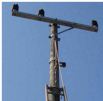
Figura 17 – Ancoragem na ferragem do poste
