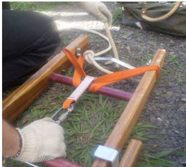
Figura 12 – Instalação do ponto de ancoragem
