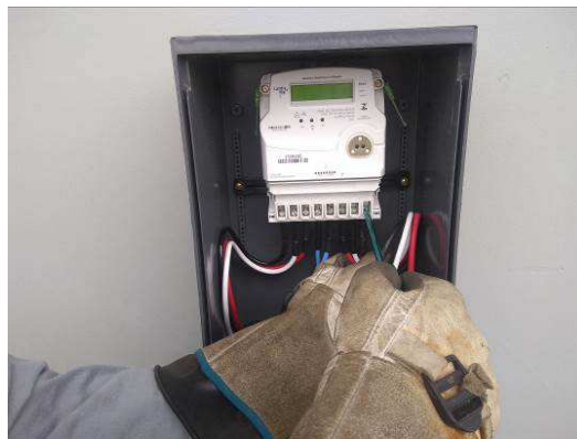
Figura 3 – Retirada do condutor de saída
